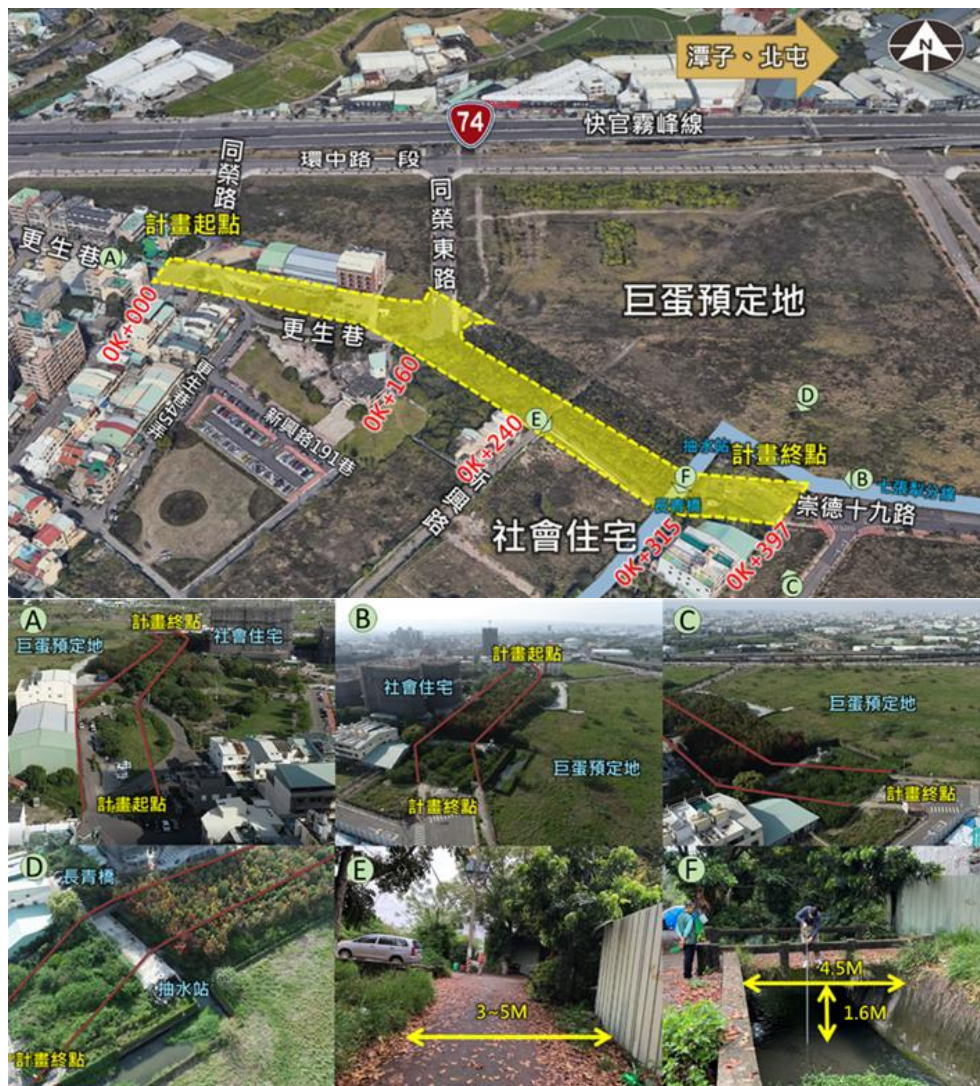
圖 2-1 北屯區崇德十九路延伸至更生巷 25M 計畫道路開闢工程道路狀況
