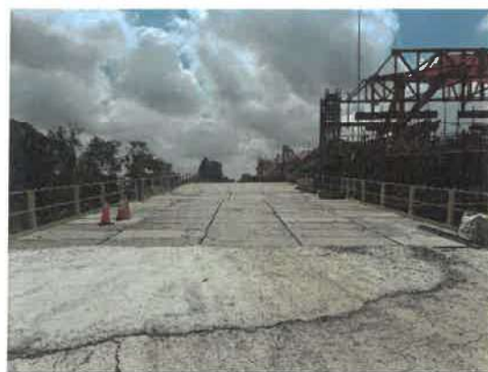
日期：115/04/30 說明：施工便橋東側
