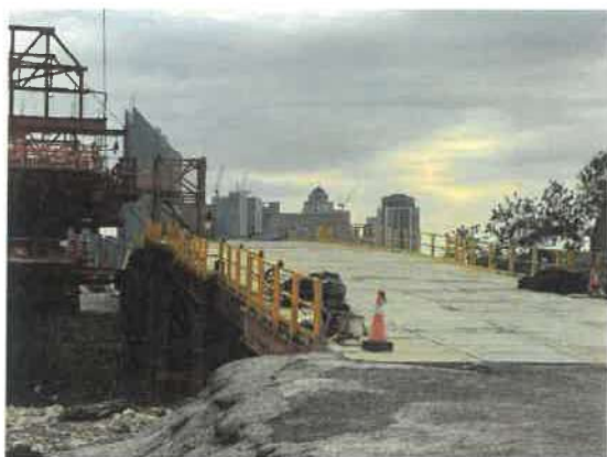
日期：115/04/30 說明：施工便橋西側
