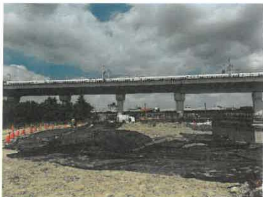
日期：115/04/30 說明：1K+418 集水坑位置
