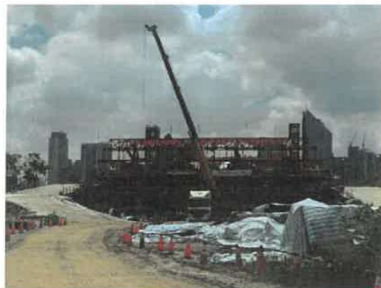
日期：115/04/30 說明：1K+500 P1 工區位置
