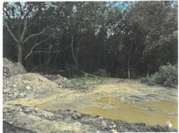
日期：115/05/28 說明：工區 1K+560 南側次生林警示線設置
