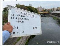
牛埔橋改建工程 保留計畫區西北側護岸次生林 日期: 111/2/17
